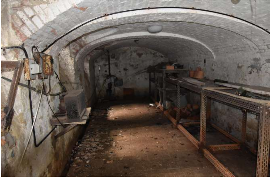
Figura 128 Cantina ottocentesca rivestita in laterizio. Fonte: archivio personale Sopralluogo 07/06/2022.
