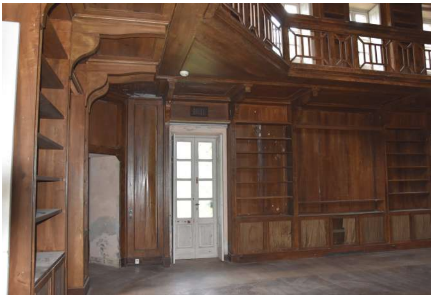
Figura 186 Rilievo fotografico "Stanza Grande". Fonte: archivio personale Sopralluogo 07/06/2022.
