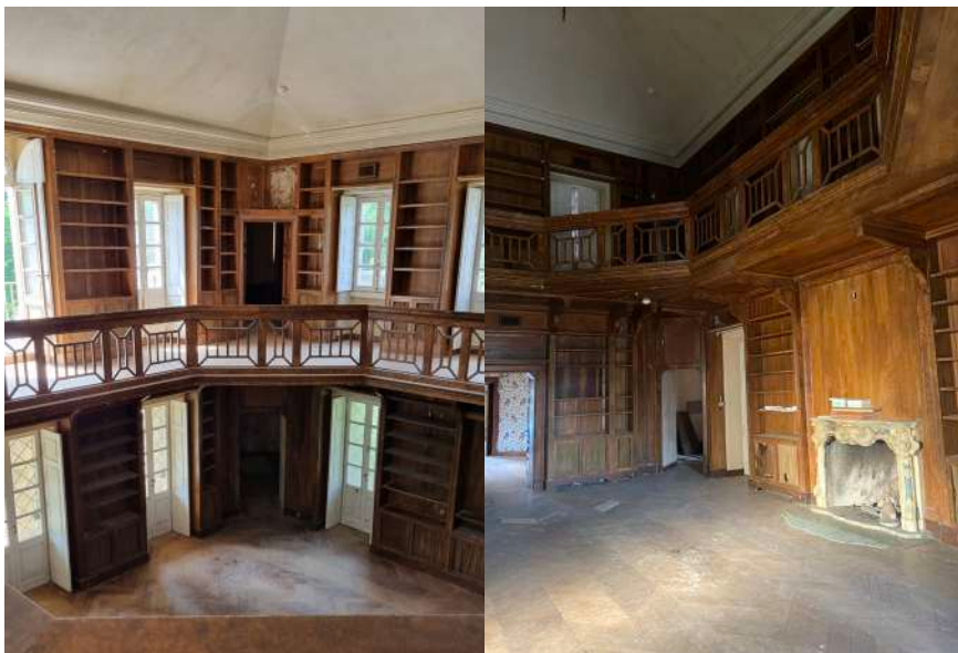
Figura 187 Rilievo fotografico "Stanza Grande". Fonte: archivio personale Sopralluoghi 07/06/2022 e 22/12/2022.
