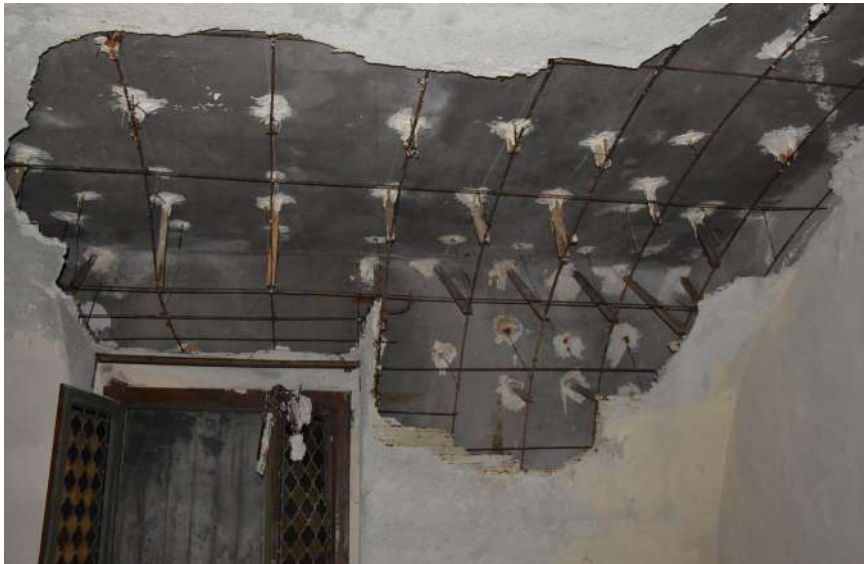
Figura 125 Sistema costruttivo delle volte presenti nella chiesa. Fonte: archivio personale Sopralluogo 07/06/2022.
