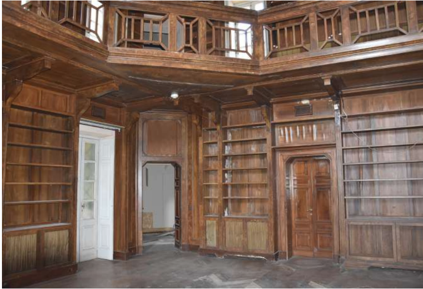
Figura 185 Rilievo fotografico "Stanza Grande". Fonte: archivio personale Sopralluogo 07/06/2022.
