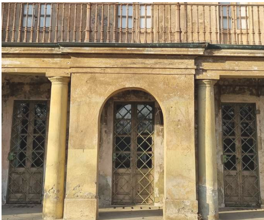
Figura 169 Fenomeno dell'alterazione cromatica. Fonte: archivio personale Sopralluogo 07/06/2022.
