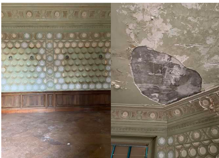
Figura 181 Rilievo fotografico sala da pranzo. Fonte: archivio personale Sopralluogo 22/12/2022.
