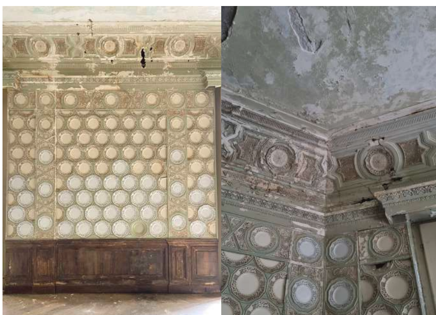
Figura 182 Rilievo fotografico sala da pranzo. Fonte: archivio personale Sopralluoghi 07/06/2022 e 22/12/2022.
