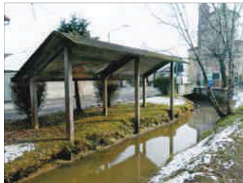
Lavatoio fatto costruire in epoca fascista
